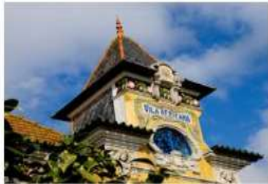
Figura 9- Edifício Arte Nova
