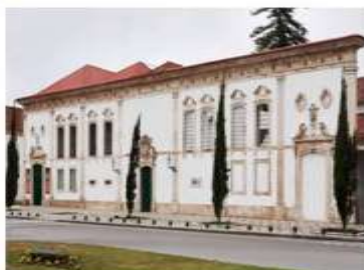
Figura 4 - Fachada do Museu de Aveiro
