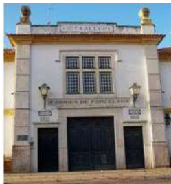
Figura 13 – Fachada da Fábrica da Vista Alegre
